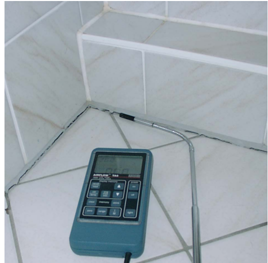
Abbildung 22: Abriss der Kachelfuge. Keine Leckage messbar. Die Luftdichtheitsebene verläuft als durchgehender Putz auf der Außenwand hinter der Vormauerung.
