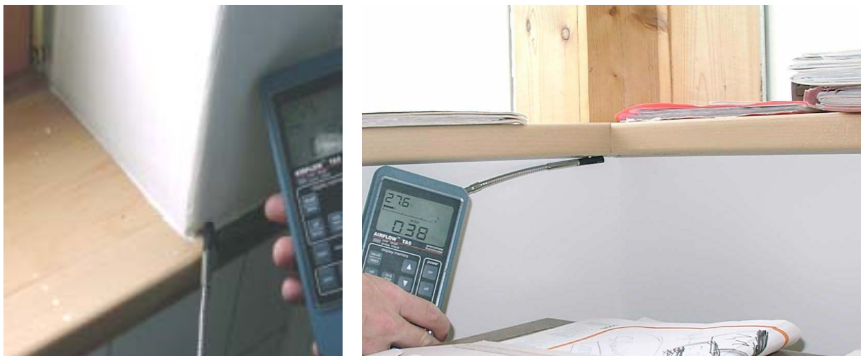
Abbildung 54: Restleckagen am Übergang Fensterbank an Wandelement (links: Fenster EG, rechts: Festverglasung 2. OG).
