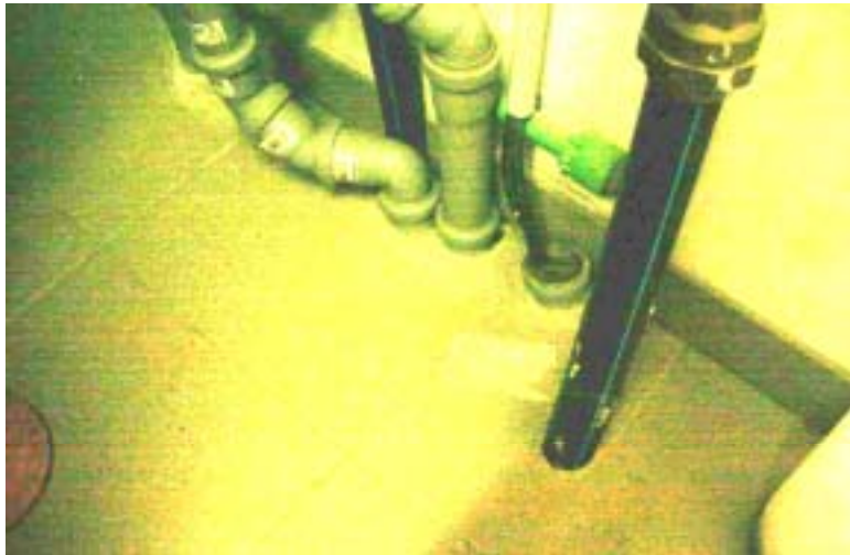
Abbildung 44: Durchdringungen für die Versorgungsleitungen.
