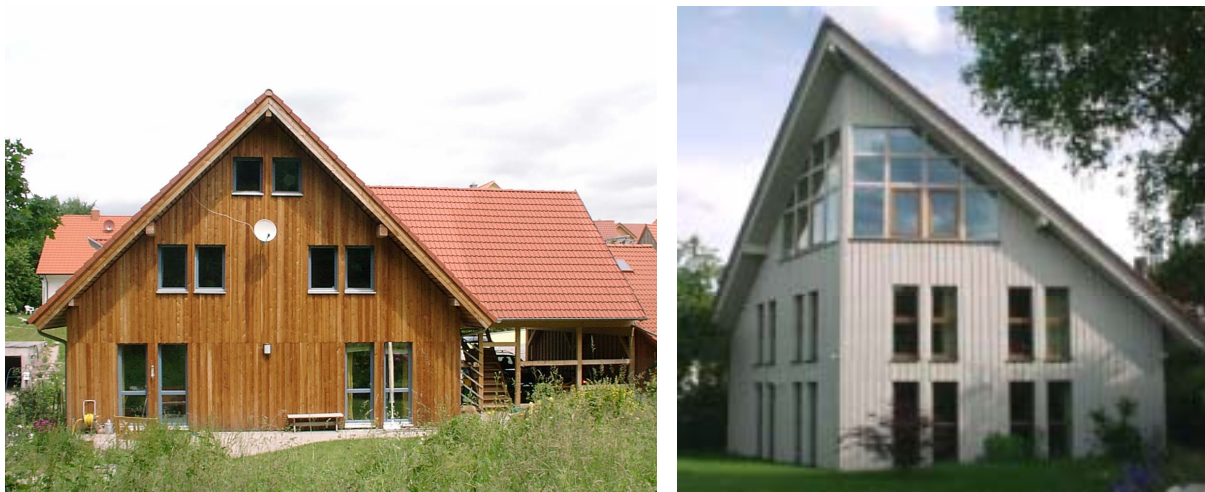
Abbildung 49: Die beiden Passivhäuser in Stegaurach/Mühlendorf (links) und in Bamberg (rechts) mit den großen Verglasungsflächen nach Norden, bei denen die Nachmessungen zur Luftdichtheit durchgeführt wurden.
