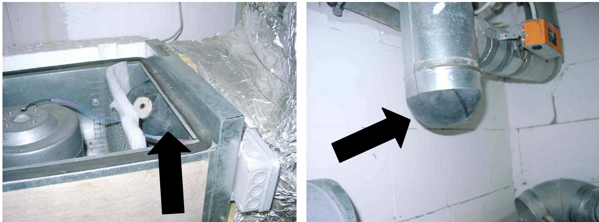
Abbildung 12: Abdichten des Lüftungssystems am Zentralgerät im Untergeschoss.
