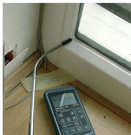
Abbildung 19: Leckagen an Fensterversatzschalen. Riss in Rahmendämmung.
