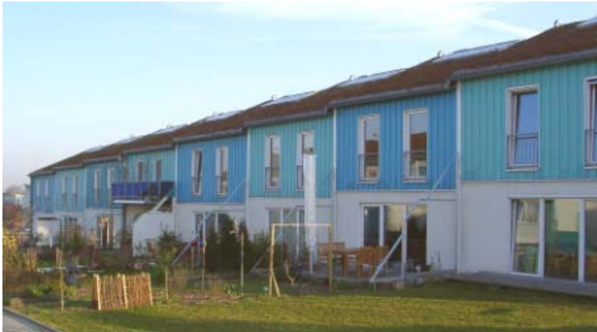
Abbildung 60: Südfassade einer Reihenhausezeile der Passivhaus-Siedlung in Hannover-Kronsberg im April 2003.
