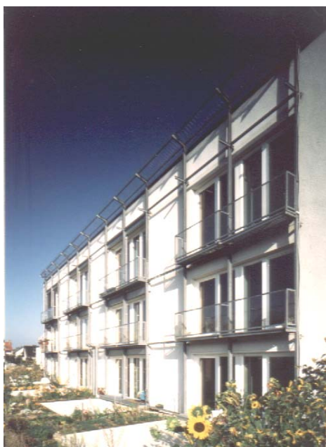
Abbildung 10: Ansicht der Passivhauszeile in Darmstadt Kranichstein (Südfassade)
