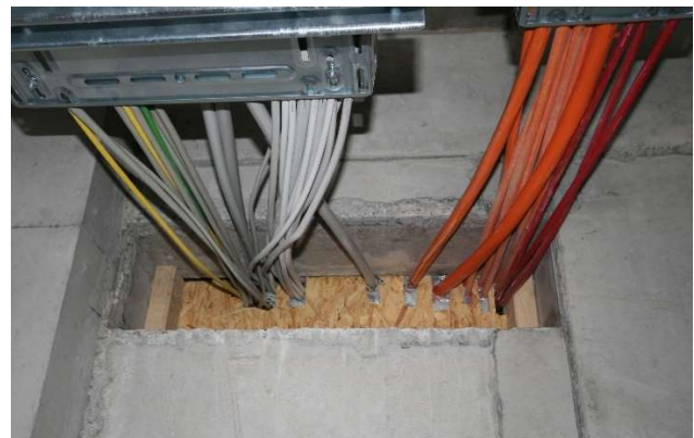
Abbildung 13: Durchführung der Blower Door Messung zur Feststellung der Gebäudeluftdichtheit am 13.03.2013. Links: Eingebauter Ventilator im EG (Nord-Ost Fassade). Rechts: Temporäre Abdichtung von Kabeldurchführungen. Diese wurden später dauerhaft verschlossen.
