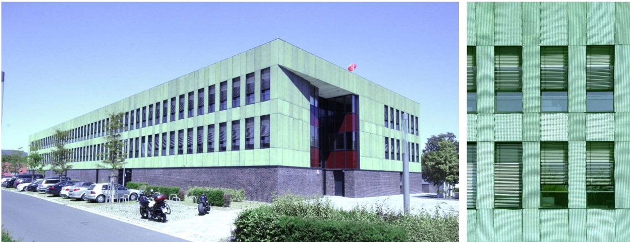
Abbildung 2: Links: Süd-West Fassade und Eingangsbereich Süd-Ost. Rechts: Detailansicht Fassade
