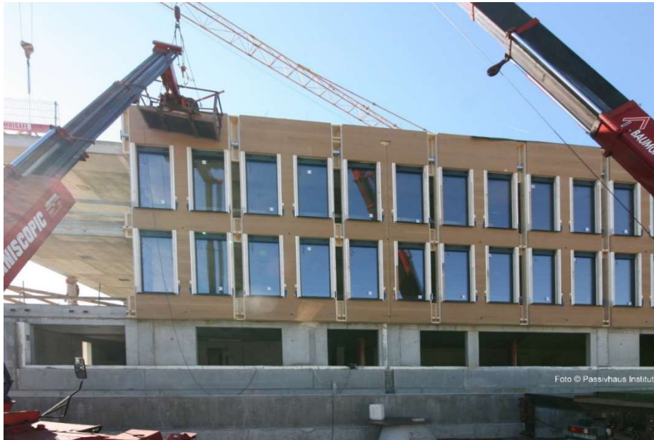
Abbildung 4: Montage der vorgefertigten Fassadenelemente.
