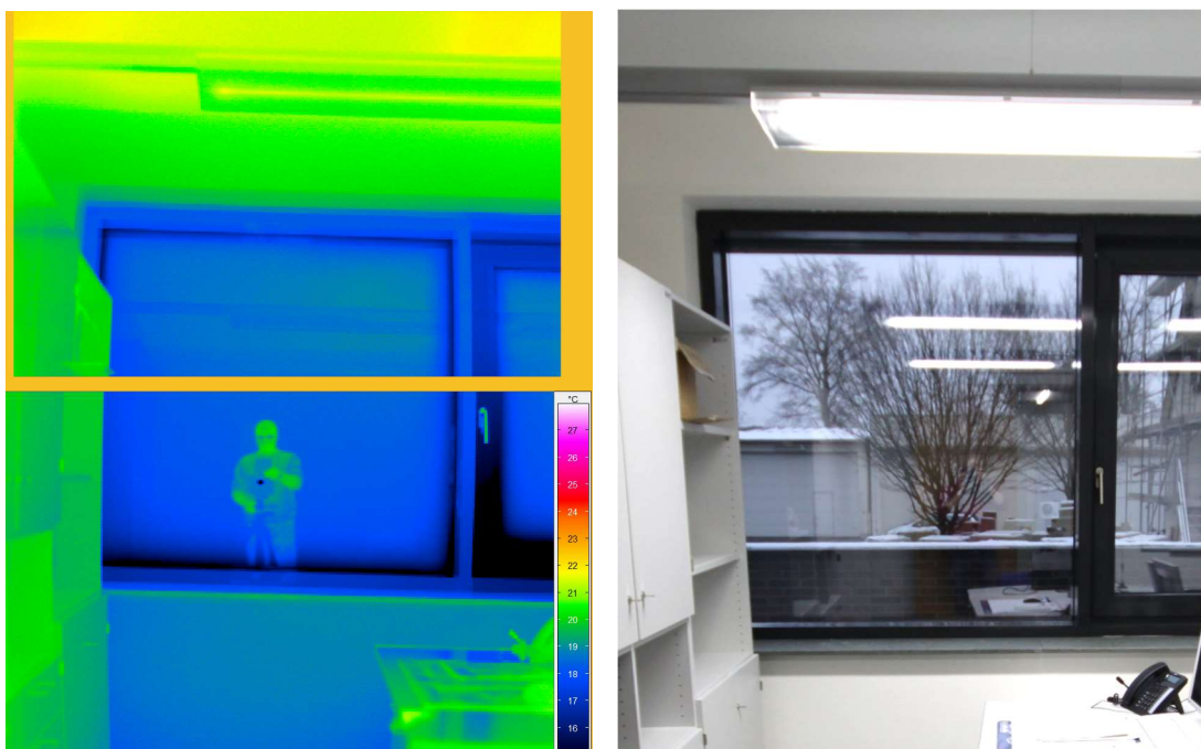
Abbildung 9: Innenthermographie eines Büroraumes im EG mit Außenwand, Fenster und Decke (aus zwei Aufnahmen montiertes Bild).
