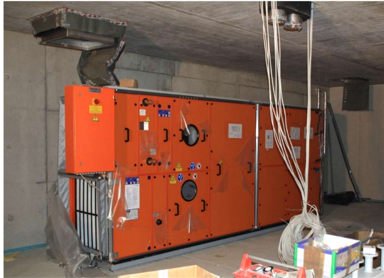
Abbildung 62: Das Lüftungsgerät während der Bauphase, links oben der Fortluftkanal über Dach, rechts oben im Hintergrund der Außenluftkanal über Dach.
